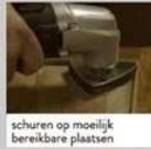
schuren op moeilijk bereikbare plaatsen
